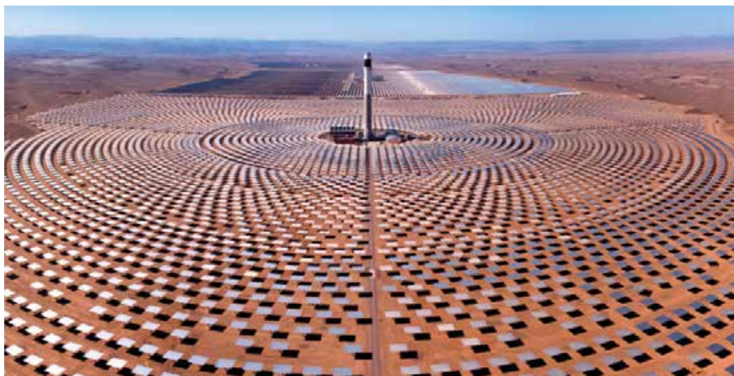
Ηλιοθερμικός σταθμός στο Μαρόκο
