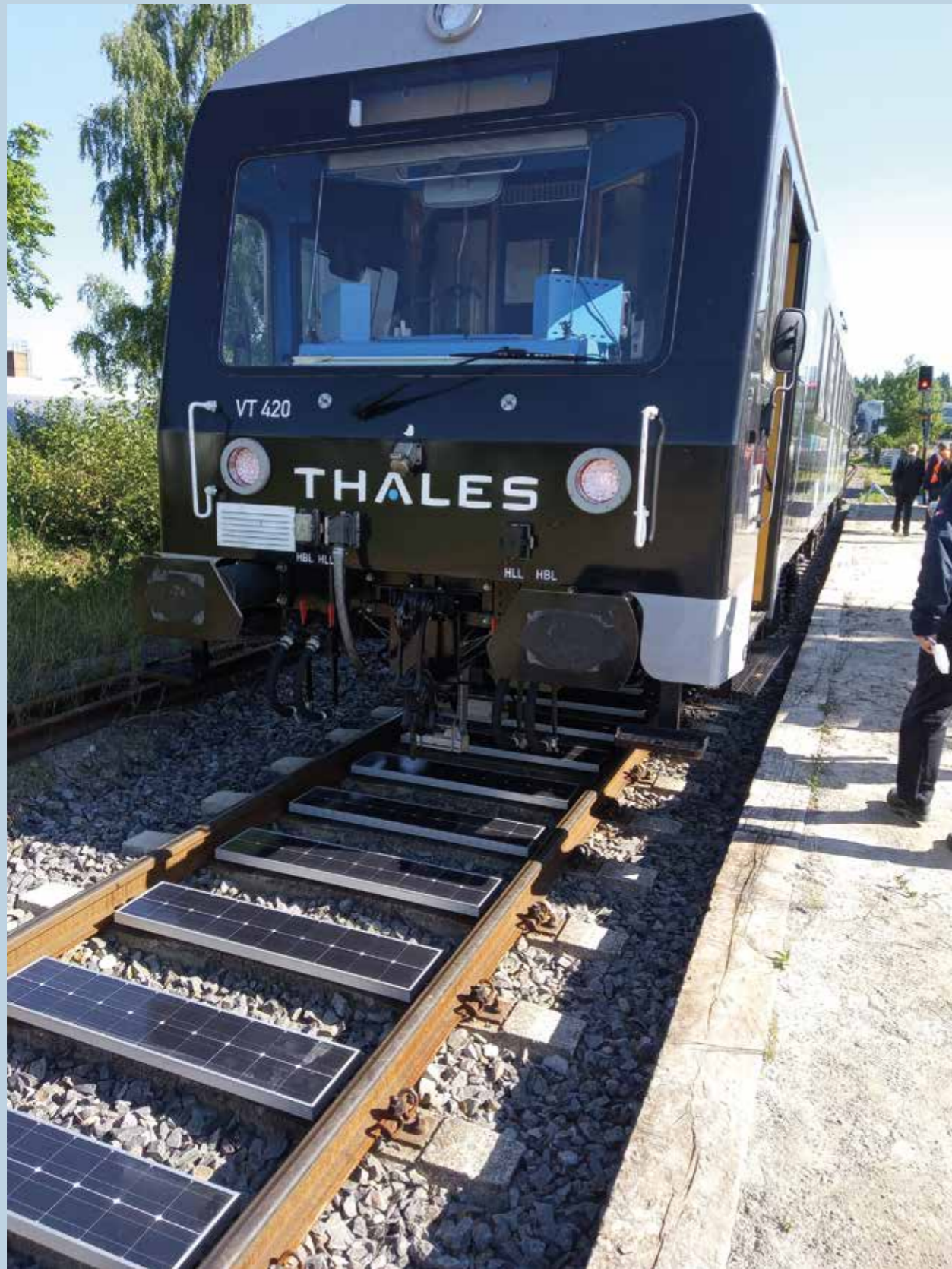
Ηλιακά πάνελ μπορούν να τοποθετηθούν ακόμα και στις τραβέρσες των σιδηροδρομικών γραμμών. Φωτογραφία από το project Bankset/ Deutsche Bahn που εφαρμόζεται στη Γερμανία (φωτο: Bankset)
